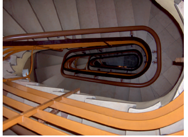
Apartman içi Merdiven Asansörü
