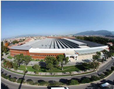
MERİNOS FABRİKA (Kule)
