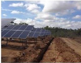
Güneş paneli ile , kuyu - depo , sulama kontrol sistemlerinde elektrik enerjisi olmayan yerlerde elektrik enerjisi üretimi ve uygulamaları
