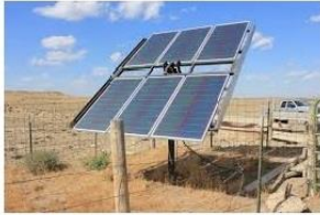
Güneş paneli ile , kuyu - depo , sulama kontrol sistemlerinde elektrik enerjisi olmayan yerlerde elektrik enerjisi üretimi ve uygulamaları
