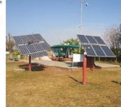
Güneş paneli ile , kuyu - depo , sulama kontrol sistemlerinde elektrik enerjisi olmayan yerlerde elektrik enerjisi üretimi ve uygulamaları
