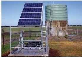
Güneş paneli ile , kuyu - depo , sulama kontrol sistemlerinde elektrik enerjisi olmayan yerlerde elektrik enerjisi üretimi ve uygulamaları
