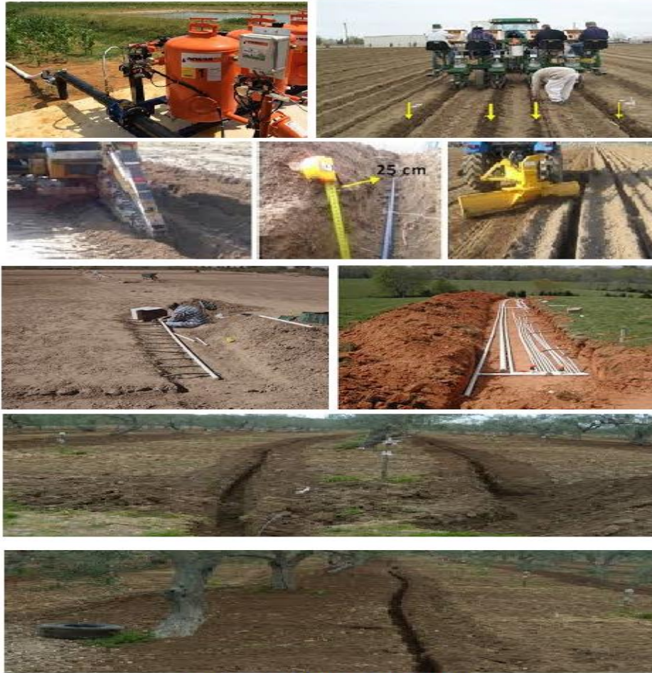
Toprak altı damlama sistem kurulumu
