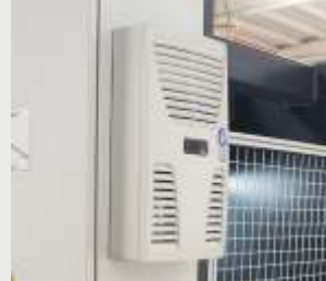
Elektrik Kabin Soğutma Sistemi
