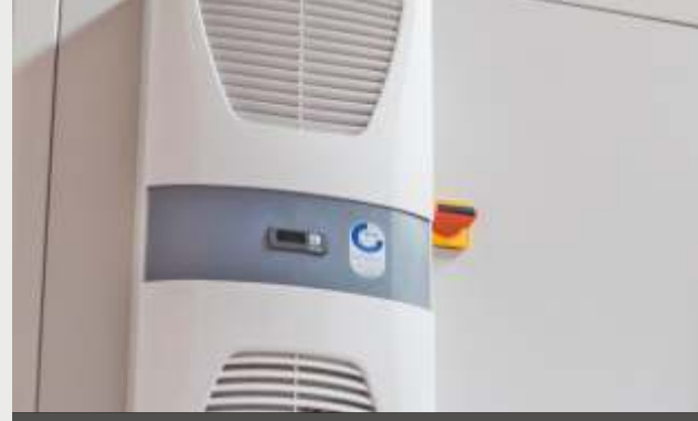
Elektrik Kabin Soğutma Sistemi
