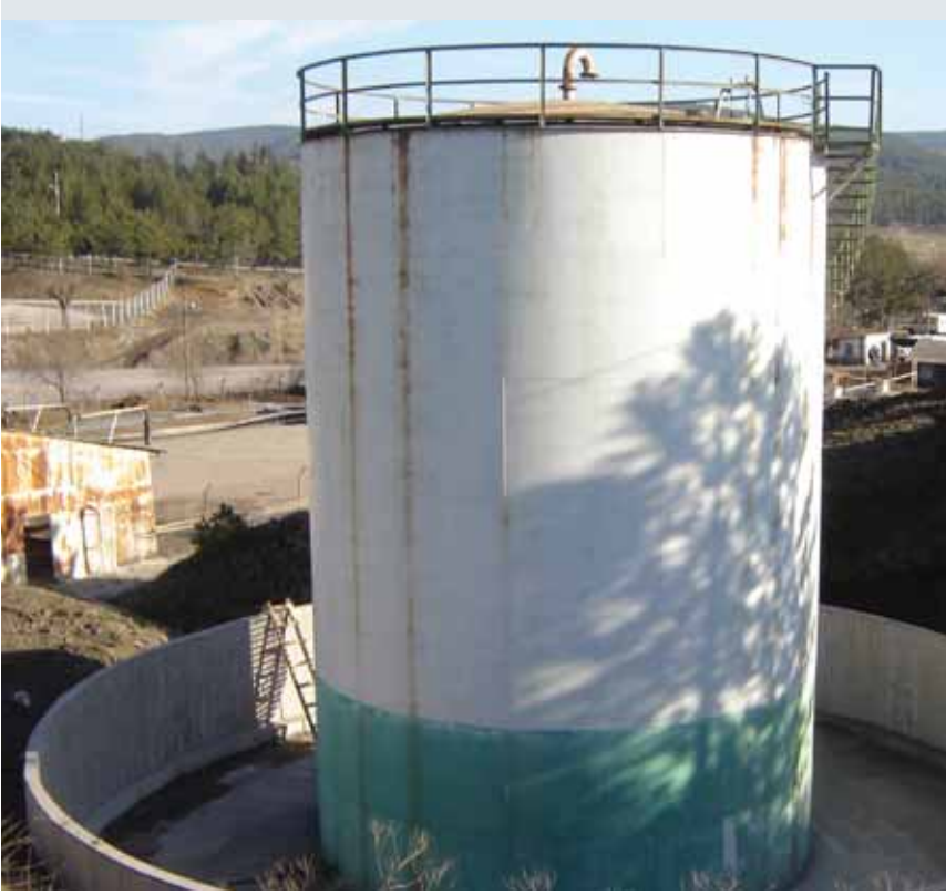
Garp Linyitleri İşletmesi - Yangın Hidrant Sistemi / Garp Lignite Enterprise - Fire Hydrant System
