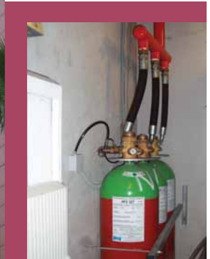
Capitol AVM - FM200 Gazlı Yangın Söndürme Sistemi / Capitol Shopping Mall - FM 200 Fire Suppression System
