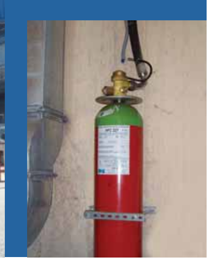
Assan Panel- Gazlı Yangın Söndürme Sistemi / Assan Panel - Gaseous Fire Suppression System
