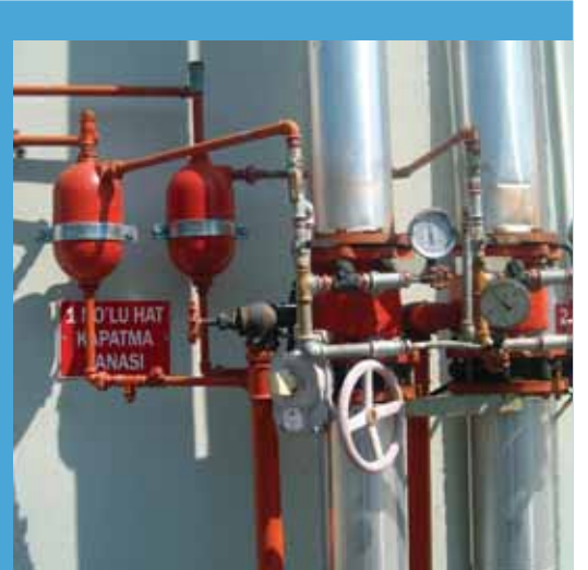
Şişecam - Sprinkler Yangın Söndürme Sistemi / Şişecam - Sprinkler Fire Extinguishing System
