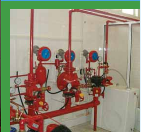
Gaziemir Hava Kuvvetleri - Islak Borulu, Kuru Borulu ve Baskın Sistem Yangın Söndürme Sistemi / Gaziemir Air Forces Command - Wet-Pipe, Dry-Pipe and Deluge Fire Protection System
