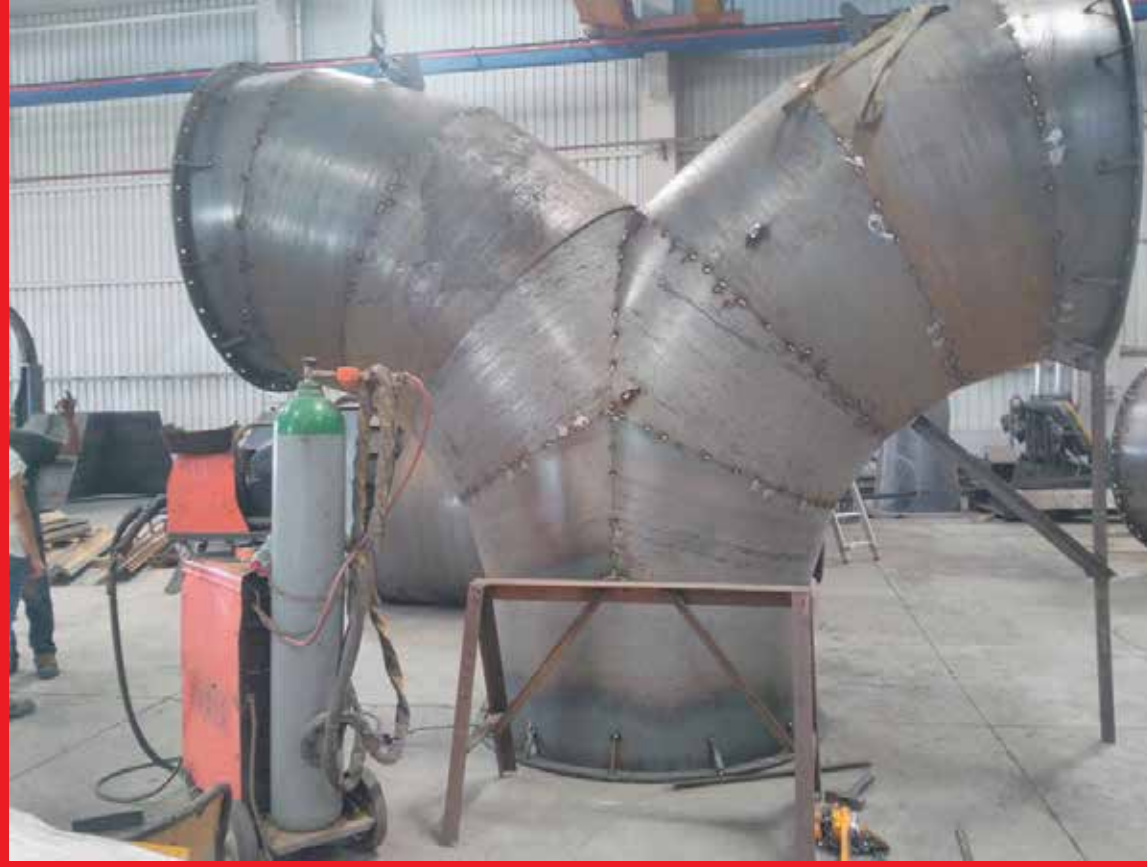
Çimento Fabrikası Gaz Dağıtıcı
