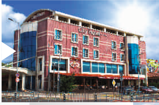
Atek Fabrika Ek Binası Hadımköy / İST.
